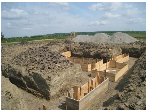
Pavilion de informare și monitorizare
